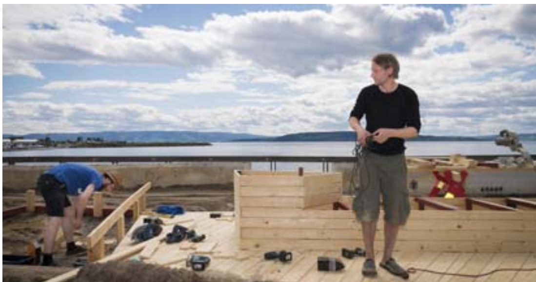
PYNTER OPP: Isaac Hegna Manning (i bakgrunnen) og Gunnar Moen i ferd med å pynte opp Sea Side-området.
